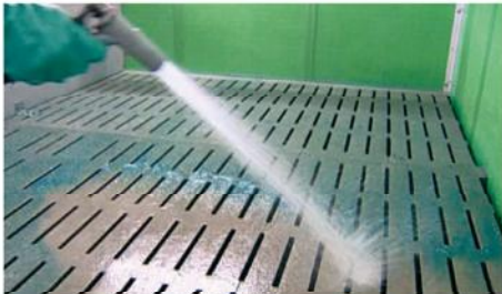
Reste vom Boden in den Kanal spülen
